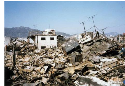
地震による被害写真
